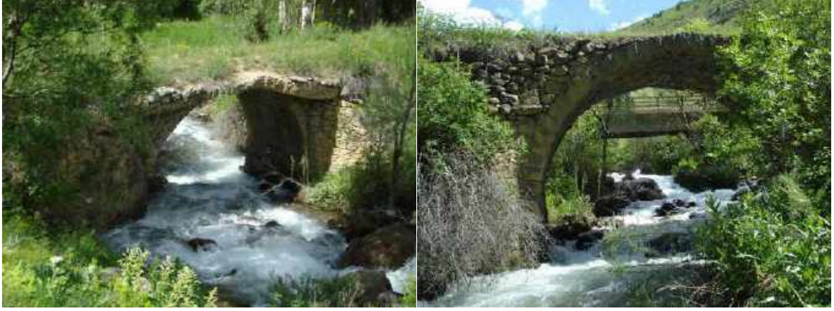
Şekil 8. Koç köyü tarihi taş kemer köprüsü.
